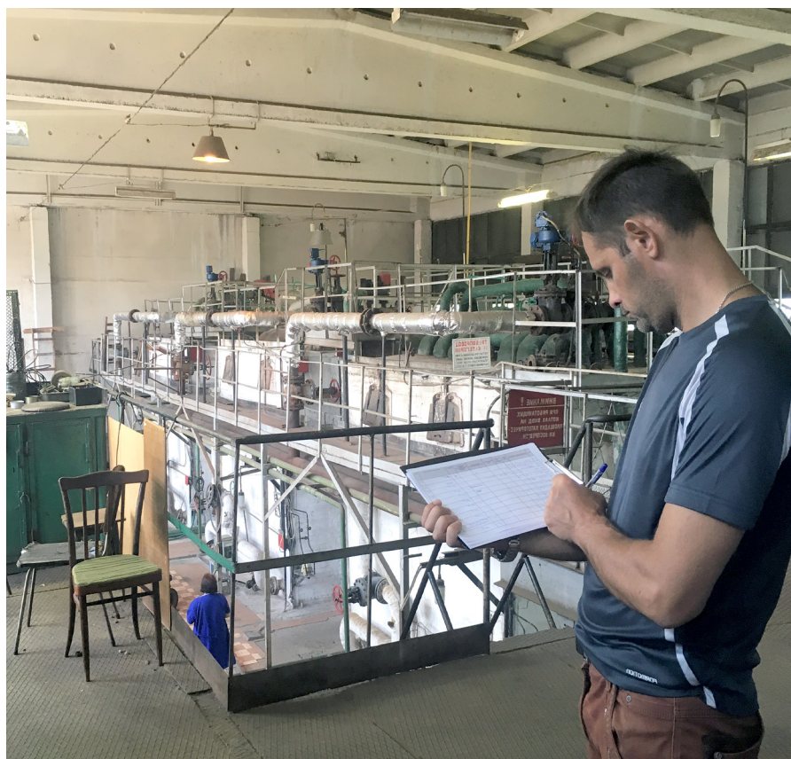
Работы проводятся в котельной.
